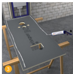
3 swissporBOARD Vorwandplatte mit swissporBOARD SB 911 Hybrid Kleb- und Dichtstoff auf dem Ständerwerk verkleben.
