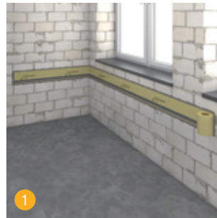
1 swissporBOARD Wannenranddichtband mit swissporBOARD Flexkleber S1 auf Höhe der Badewanne an der Wand anbringen.
