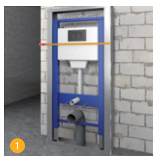
1 Vorwandelement und Ständerwerk aufbauen und ausmessen.
