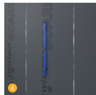
4 Alle swissporBOARD Bauplatten gleichmäßig zueinander ausrichten.
