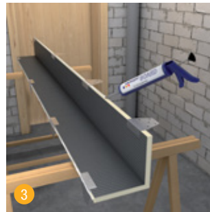
Die Stoßkanten des swissporBOARD L-Winkelements mit swissporBOARD SB 911 Hybrid Kleb- und Dichtstoff versehen.
