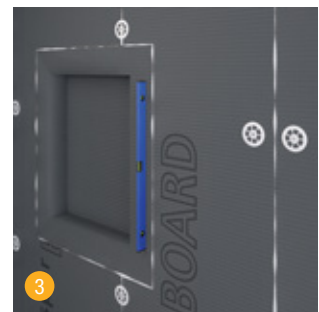
3 Alle swissporBOARD Bauplatten gleichmäßig zueinander ausrichten.
