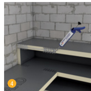
4 Alle Stoßkanten werden mit swissporBOARD SB 911 Hybrid Kleb- und Dichtstoff verklebt und abgedichtet.
