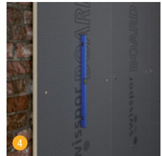
4 Alle swissporBOARD Bauplatten gleichmäßig zueinander ausrichten.
