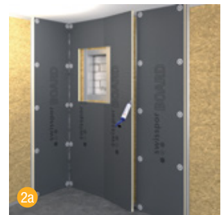
2a swissporBOARD Bauplatten mit swissporBOARD SB 911 Hybrid Kleb- und Dichtstoff auf dem Ständerwerk verkleben und festschrauben.
