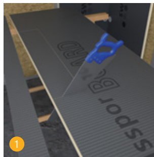
1 swissporBOARD Bauplatten zuschneiden und bei Bedarf Aussparung für die swissporBOARD Nicchia aussägen.
